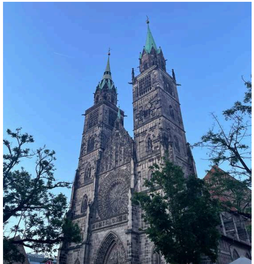
Lorenzkirche, Nürnberg (erbaut 1250)
